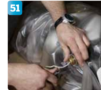
Snöret från tuben träs utanför vakuumpåsen och när allt är på plats dras muttern fast.
